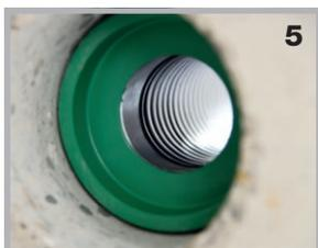
...la gaine de protection est ainsi raccordée au carottage ou au tube fourreau de manière étanche à l'eau sous pression.
