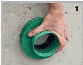
Le joint de raccordement est positionné dans le carottage / dans le tube fourreau...
