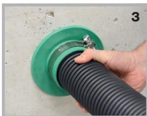
...la bande de serrage est placée sur le joint de raccordement et le tube de raccordement est inséré jusqu'à la butée...
