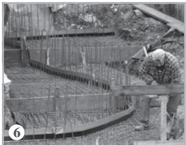
6 La tôle d'étanchéité MASTER peut être pliée dans tous les sens. Les joints peuvent être également réalisés sans problème sur des plans décalés.
