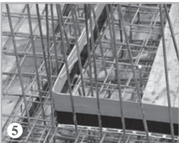
5 Fixer à l'aide de fils d'attache au rail de retenue. Plier tout simplement la zone angulaire.
