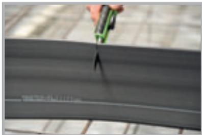
Le joint de reprise/dilatation solide se coupe facilement à l'aide d'un cutter.
