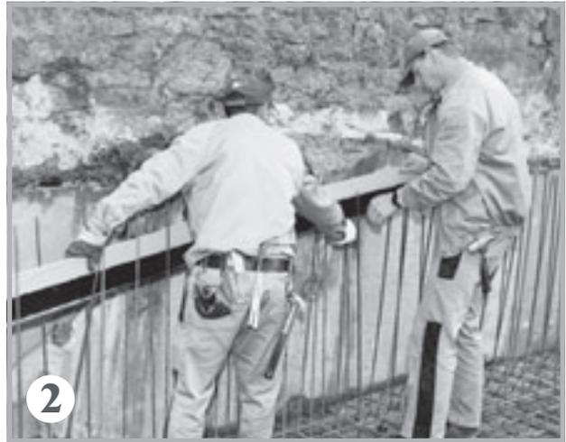
2 Poser l'élément sur la position d'armature la plus élevée.
