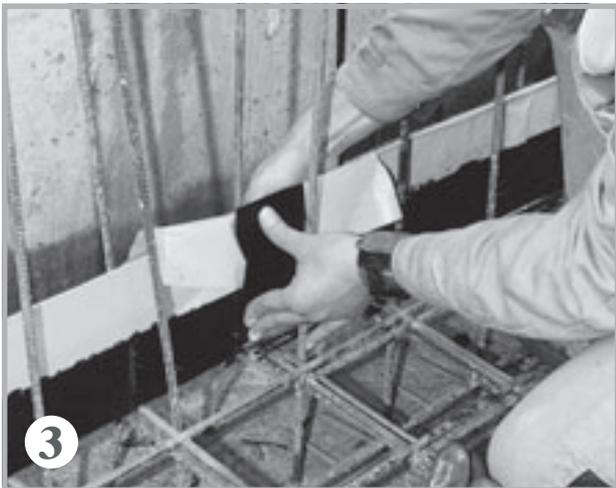
3 Recouvrir la tôle d'étanchéité MASTER sur 5 cm et presser contre l'autre tôle.
