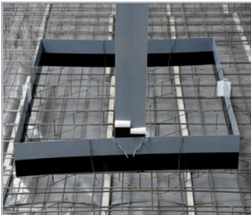
Intégration fiable dans le béton, au maximum la moitié de la largeur de la tôle. La feuille de protection supérieure est retirée avant le bétonnage du mur. Pour les tôles revêtues d'un côté, le revêtement doit toujours se trouver côté eau.
