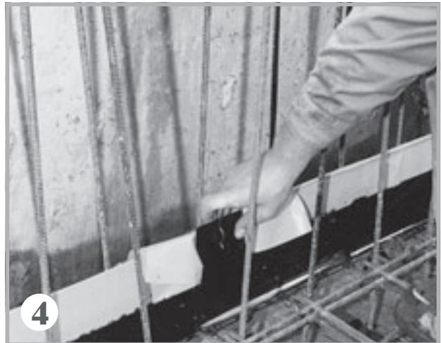
4 Sécuriser la jointure avec une goupille de sécurité.
