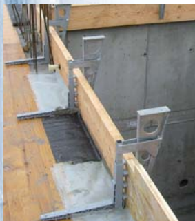
Coffrage de plafond
